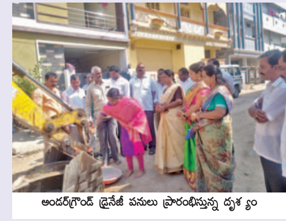
ఆండర్‌గ్రౌండ్ డ్రైనేజీ పనులు ప్రారంభిస్తున్న దృశ్య ర్థం
